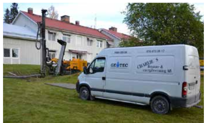
Örräsk 12:36 (Öregården) – installation bergvärme
