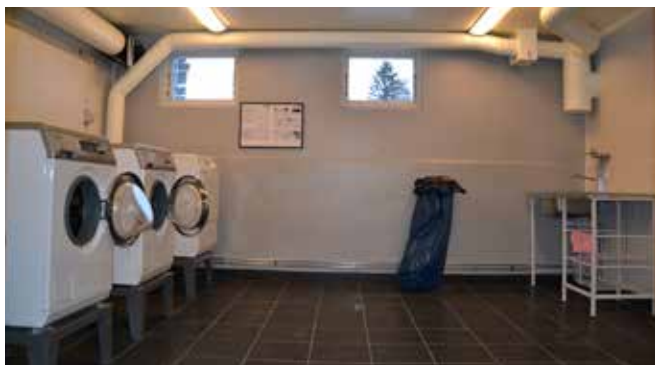
Källan 1- renoverad tvättstuga
