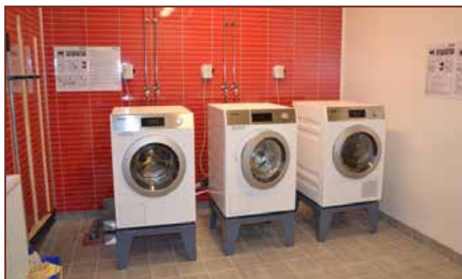
Soldaten 2: Renovering av tvättstugan samt påbörjad takrenovering.
