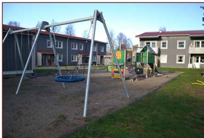
Vid Kv. Löken 1 byttes fönster och monterades ny lekplatsutrustning.
