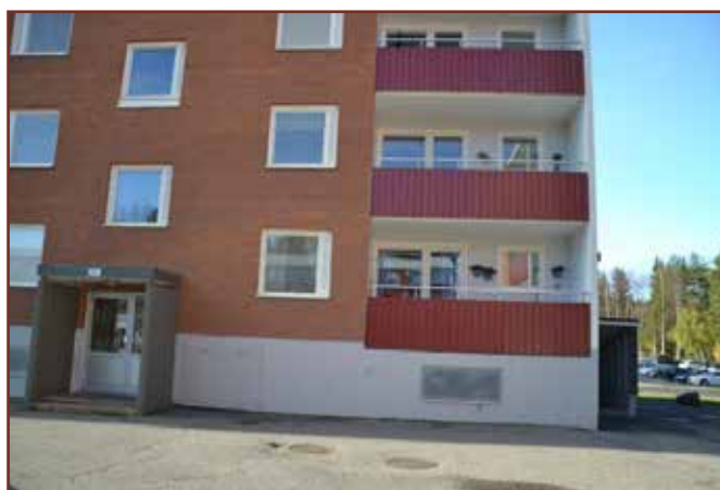
Vid Kv. Hjärtat 4-5 utfördes utvändig målning och montering av nya balkongfronter.
