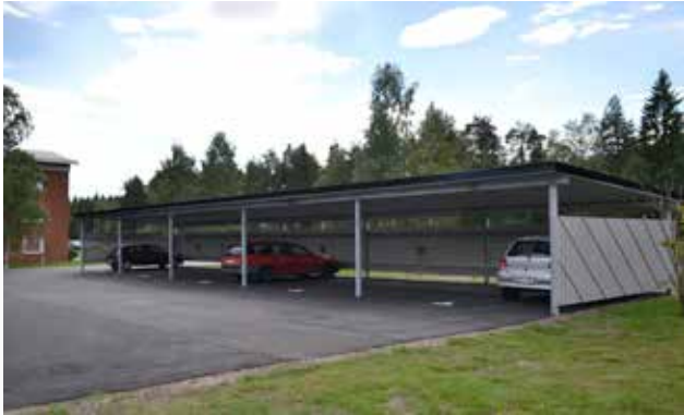
Näsan 1 – ombyggnad skärmtak
